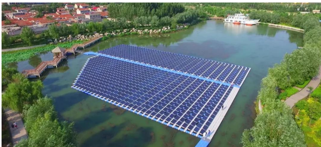
水上漂浮式光伏电站
