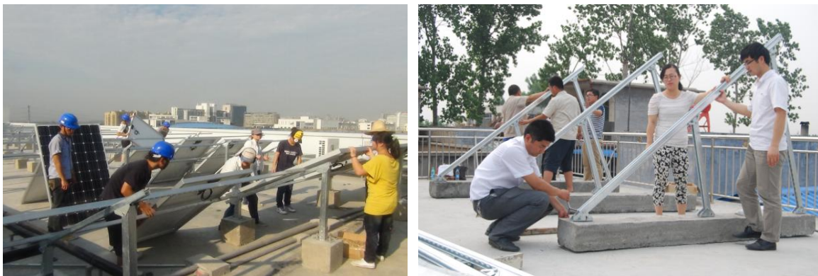
骨干教师参与泗水县、梁山县屋顶电站建设项目
